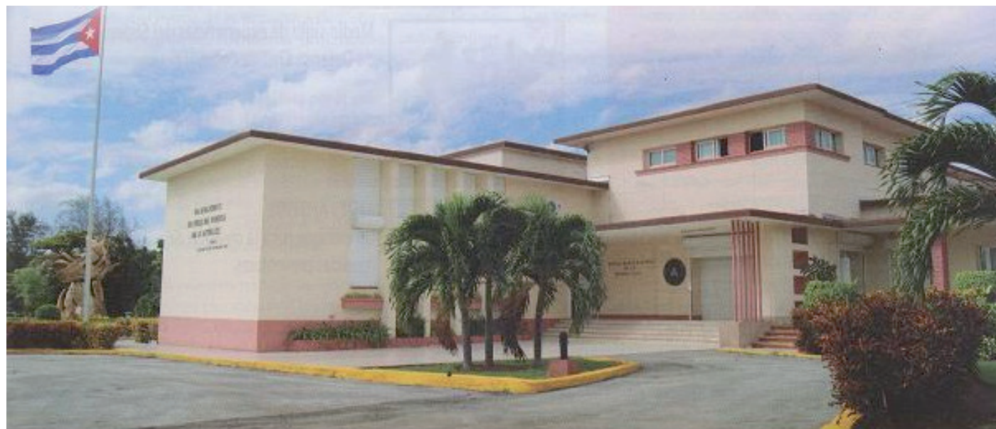
Edificio del EMNDC
