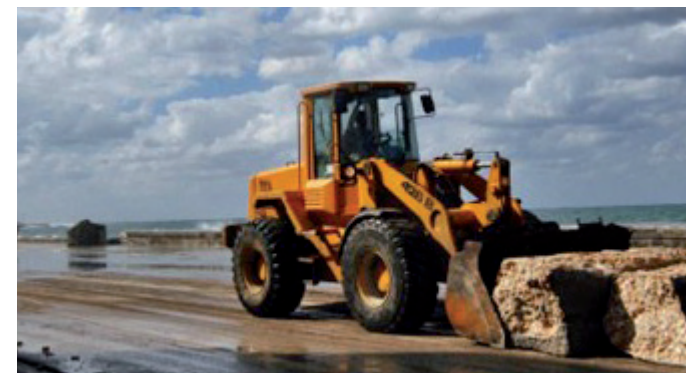
Limpiando las vías de comunicación para rehabilitar el tránsito.
