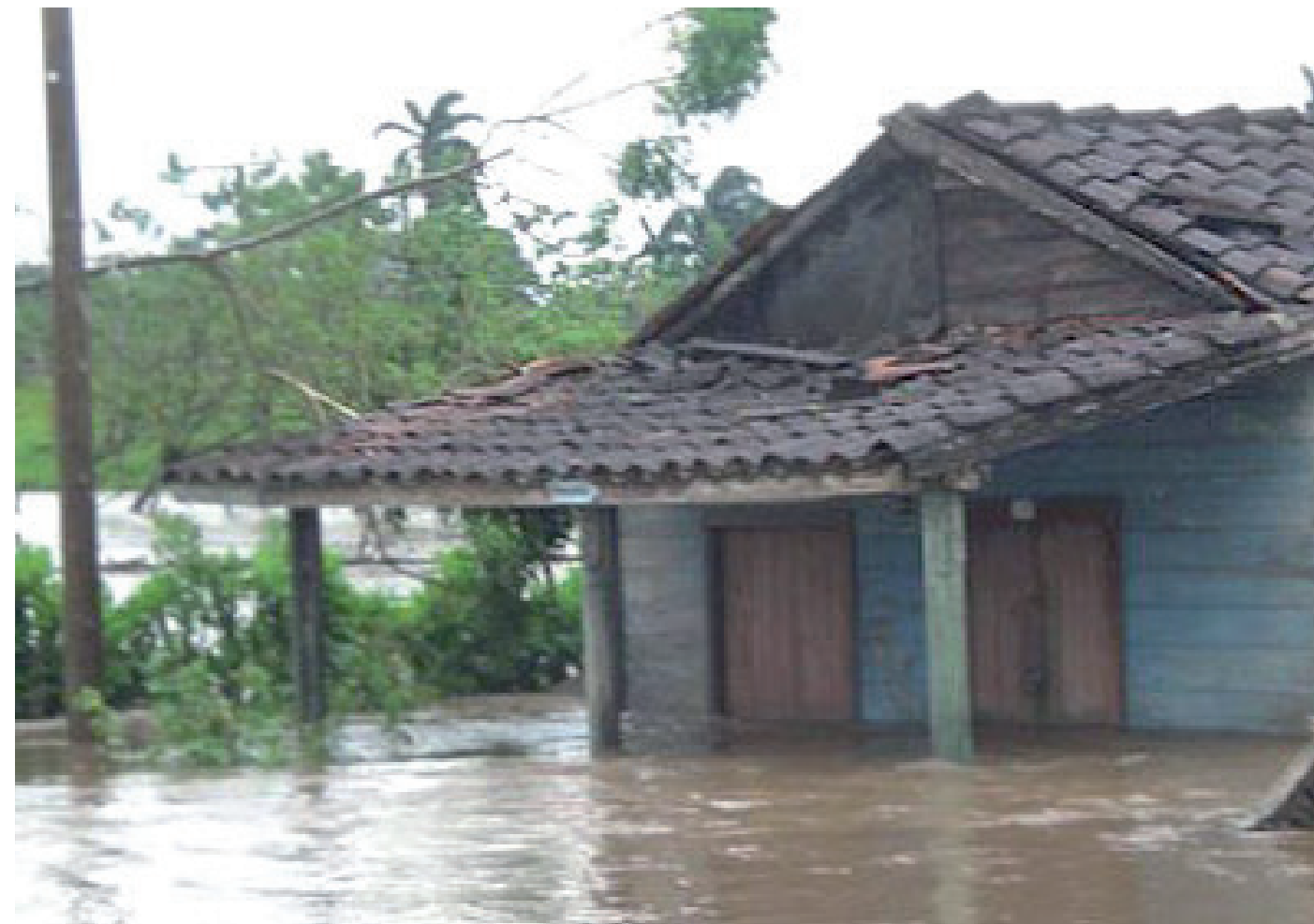
Inundaciones provocadas por intensas lluvias
