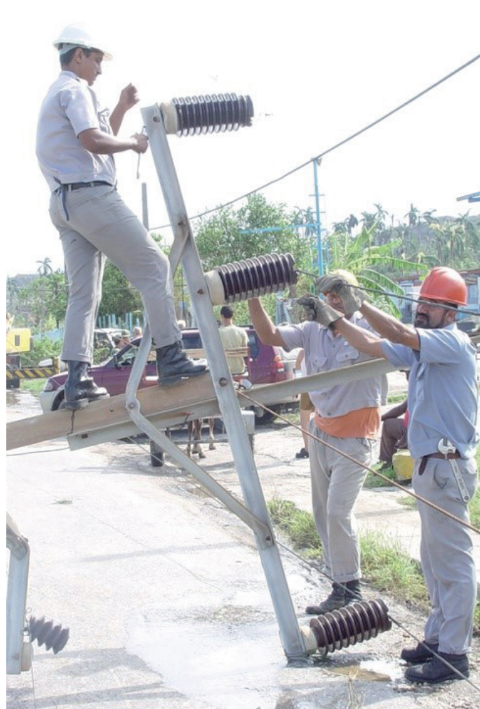
Rehabilitando el servicio eléctrico.
