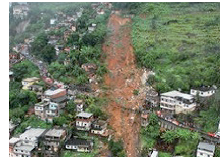
Deslizamiento de tierra en poblado construido en ladera de una elevación provocado por intensas lluvias
