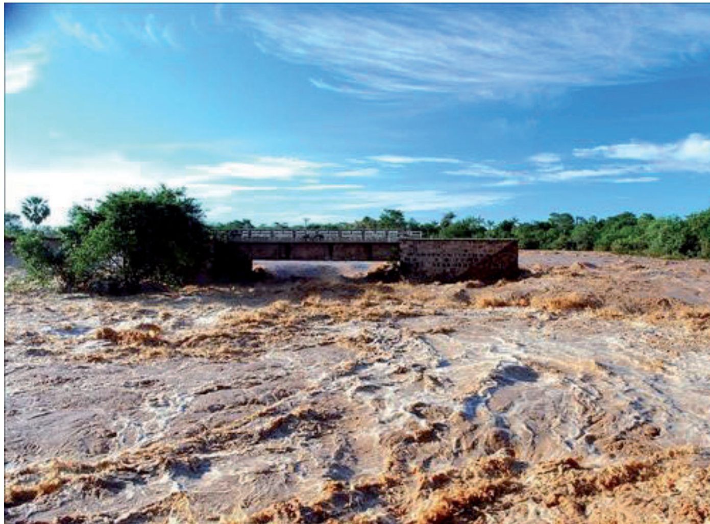
Aguas abajo de la presa
