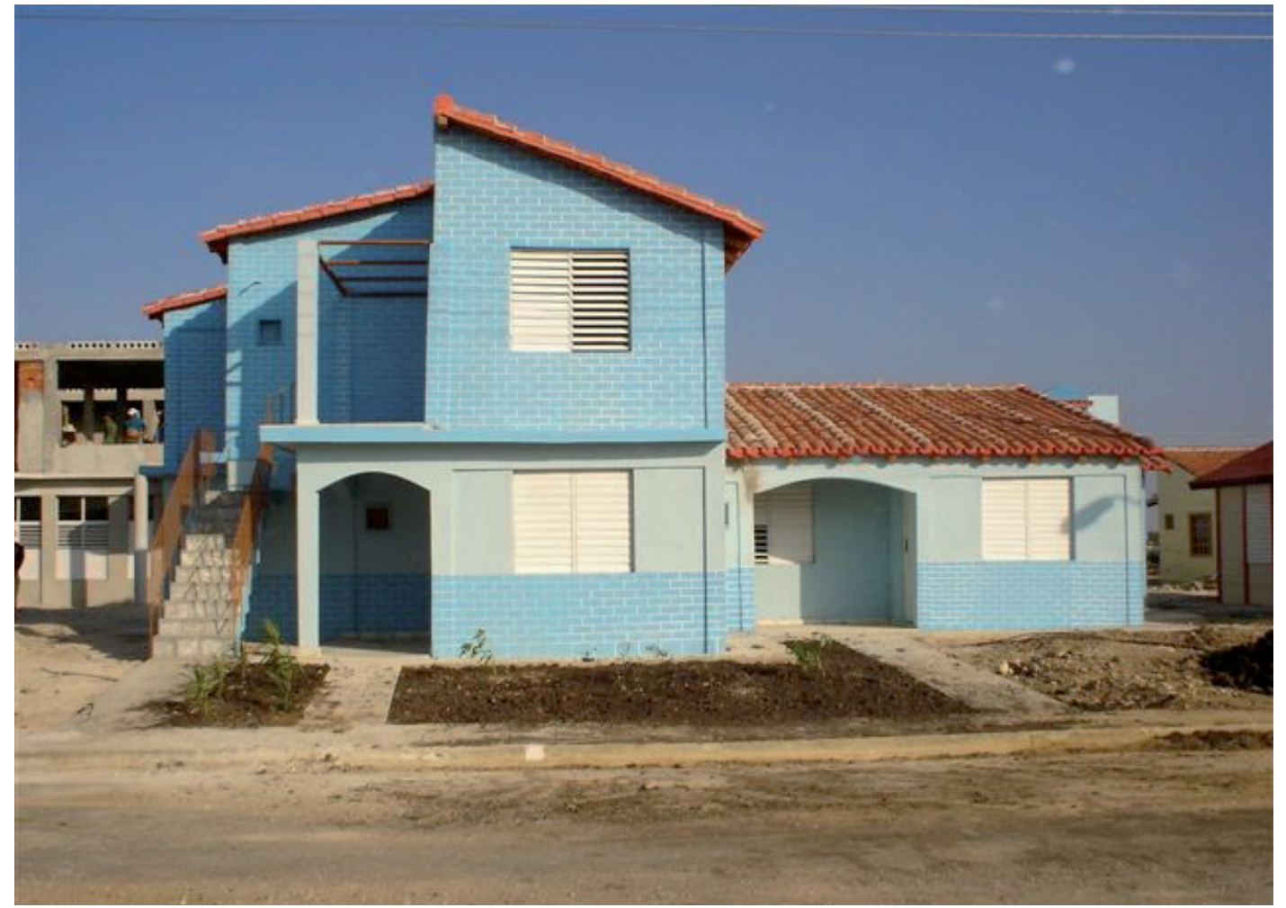
Construcción de viviendas para los damnificados.
