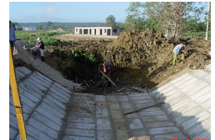
Preparación de desagües, zanjas y canales.
